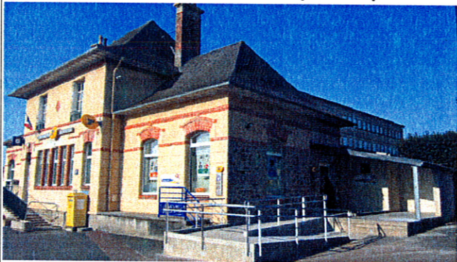
Nouvel accès à la poste pour tous.
